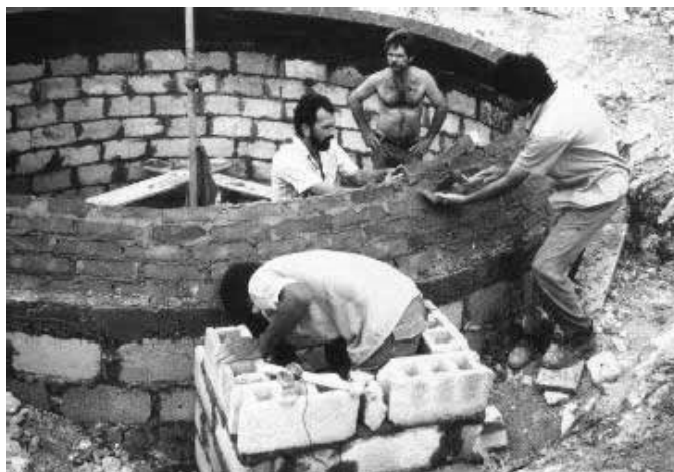
Рис. 17. Сооружение кирпичного реактора на Кубе
