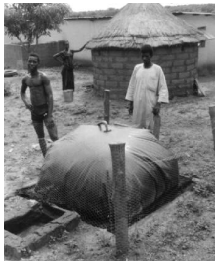
Рис.5. Баллонная установка в Кот-д'Ивуаре
