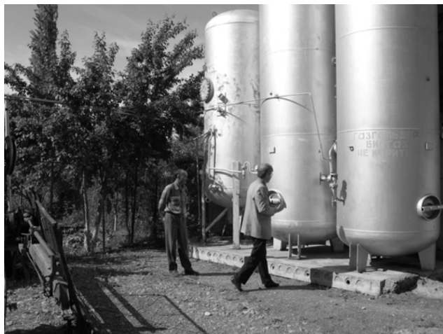
Рис.24. Стальные газгольдеры среднего давления в с. Петровка Фото: Веденев А.Г., ОФ «Флюид»
