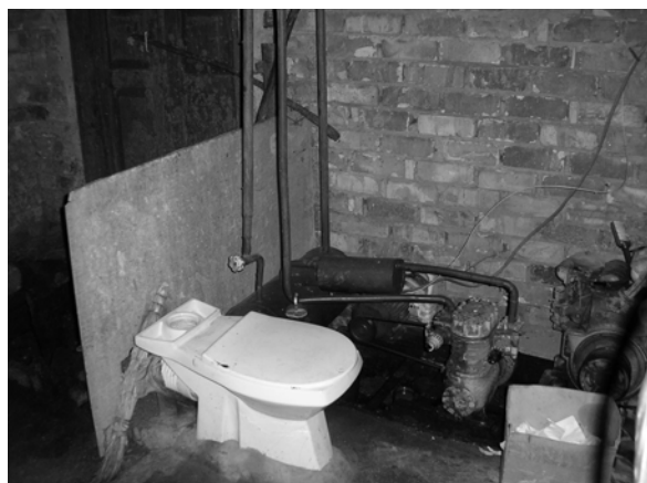
Рис. 10. Совмещенная переработка фекалий в биогазовой установке с. Беловодское Фото: Веденев А.Г., ОФ «Флюид»
