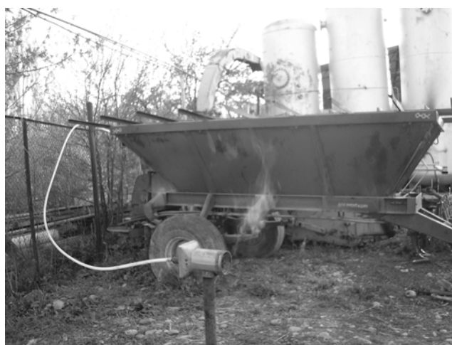
Рис.41. Факельная горелка для сжигания излишков биогаза в с. Петровка
