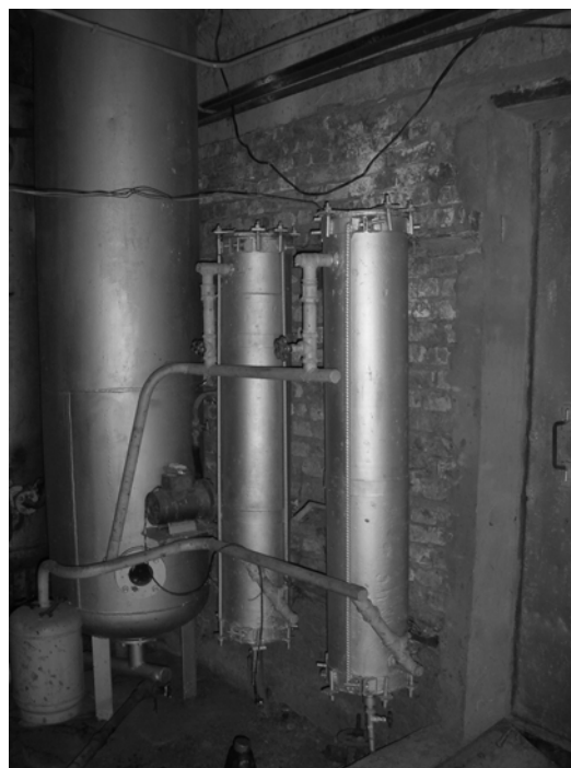
Рис.39. Сероводородный фильтр и абсорбер для отделения углекислоты в с. Петровка
