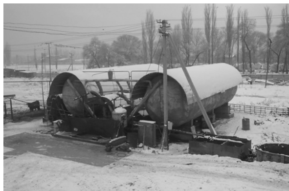
Рис. 6. Установка в ОсОО «БЕКПР»
