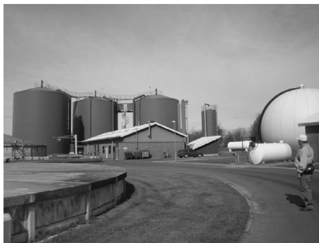
Рис.4. Промышленная биогазовая установка в Дании
